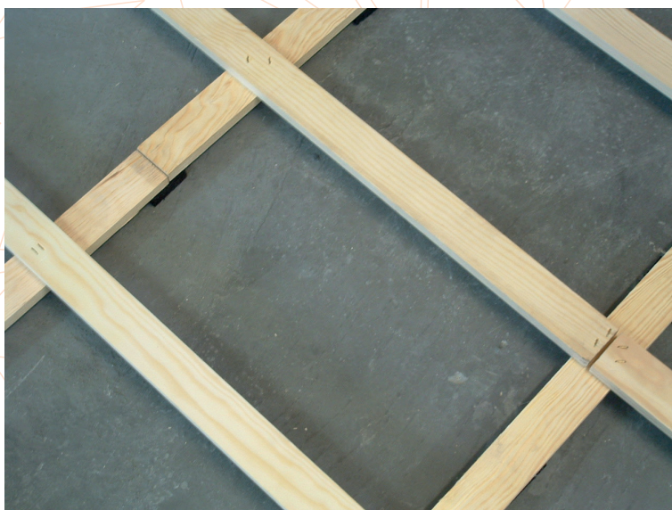
Фот. 1. Соединение нижних планок с верхними.
