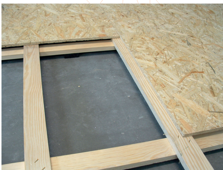
Фот. 2. Монтаж плит OSB 3 или P5 относительно планок решетки.
